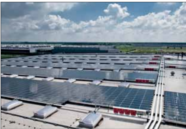
Instalación de 1 MW
