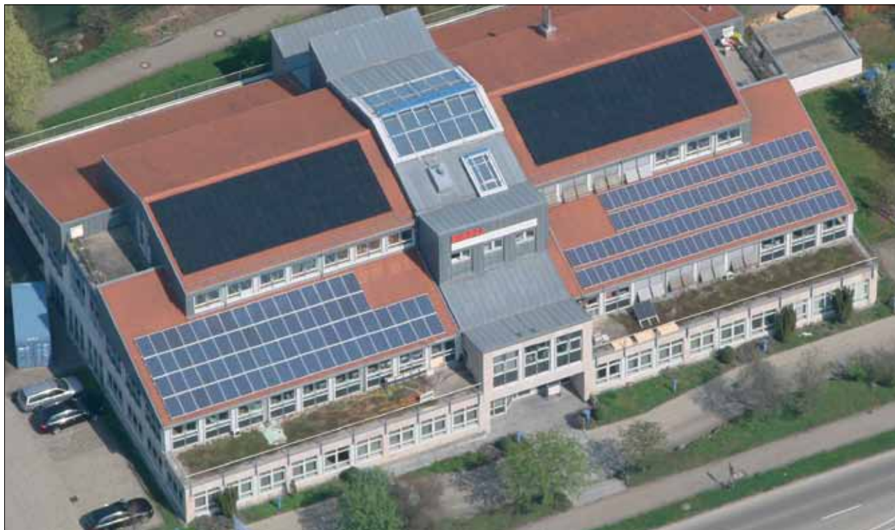
La central de REFUso/ en Metzingen
